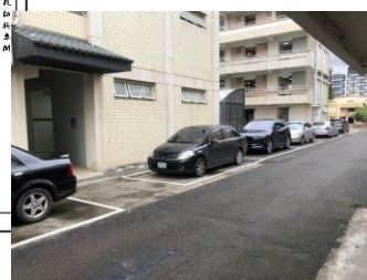
文山樓旁車道 ※車輛進出注意 ※非必要請勿逗留
